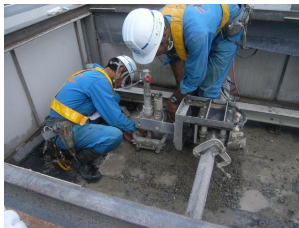
図-5 WJ装置およびXY走行装置
