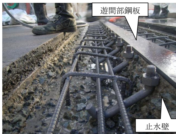
図-6 はつり完了状況
