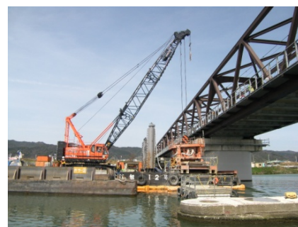
写真3. 水中部撤去状況
