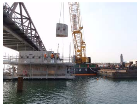
写真2. 気中部撤去状況
