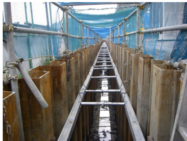
図-3 空溝対策工の設置状況
