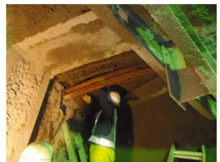
写真-2 鋼製支保工設置状況
