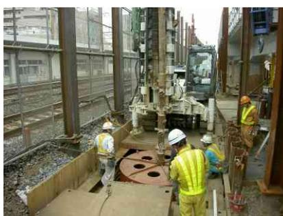
写真-5 根巻鋼管圧入
