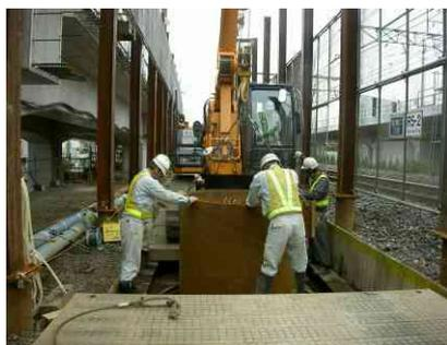
写真-4 根巻鋼管据付
