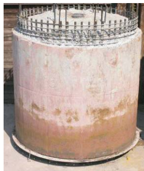
写真-2 硬化後の外観 (ケース②)
