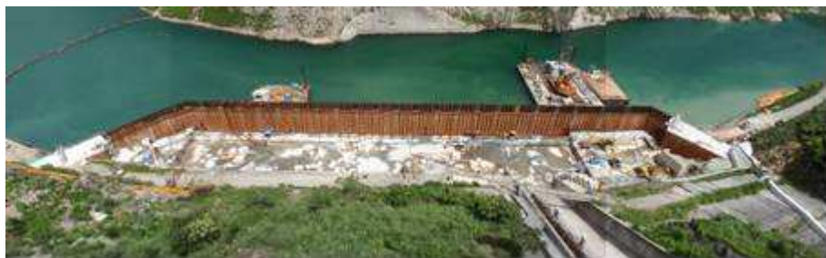
写真-4 水替え完了
