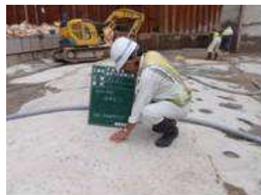
写真-5 水替え完了
