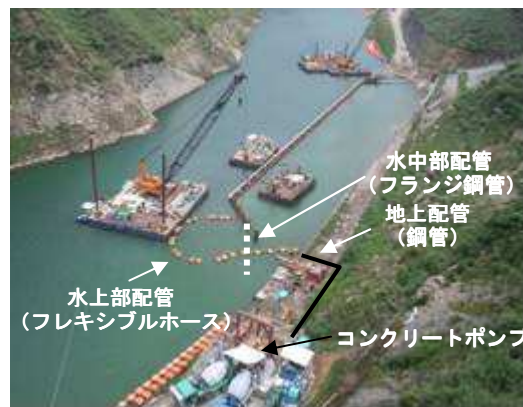
写真-3 コンクリート打設状況
