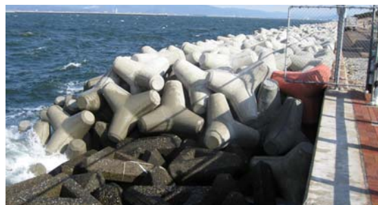
写真 4-1 復旧対策断面(施工完了)
