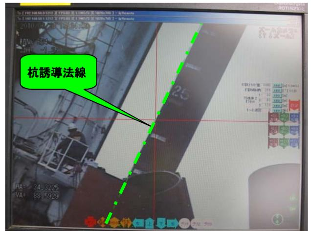
写真-1 遠隔TVによる誘導状況
