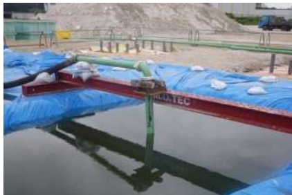
写真-2 水中打設
