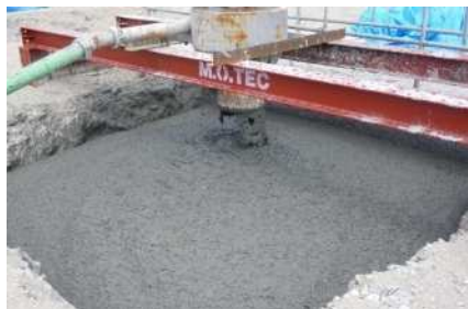
写真-1 気中打設
