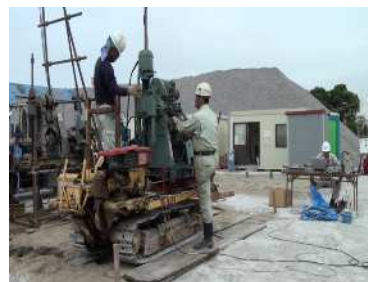
写真-3 電気式コーン貫入試験
