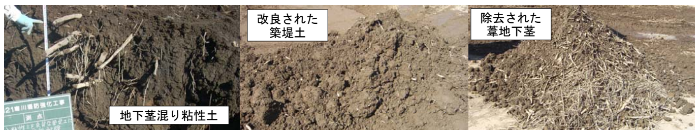
写真-2 葦地下茎混り粘性土(左)、改良された築堤土(中央)および除去された葦地下茎(右)
