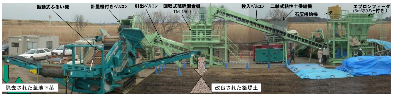
写真-1 回転式破碎混合工法のプラント
