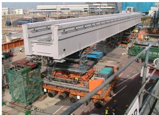
写真-1 トランスポーター・ステージジャッキによる架設状況
