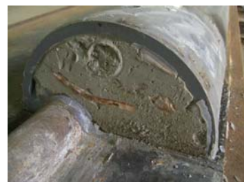
写真-1 ガイドパイプ断面
