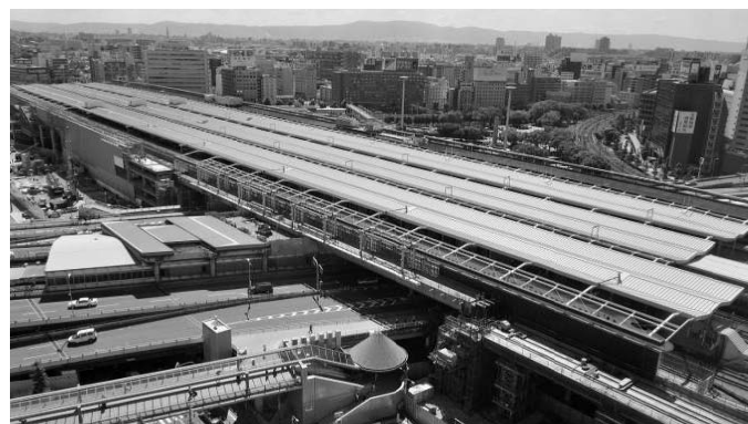
図4 送出し完了状況
