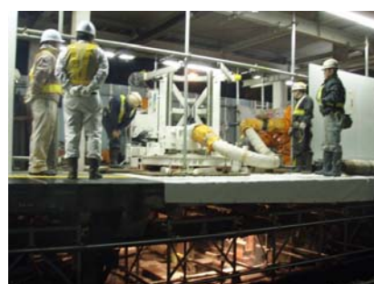
写真-3 掘削機による施工状況
