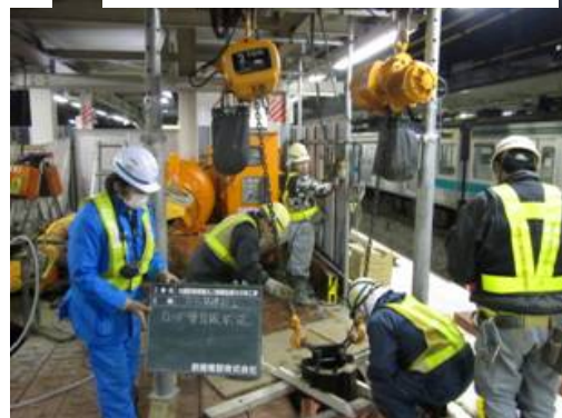
写真-5 ケリーロッド引抜状況
