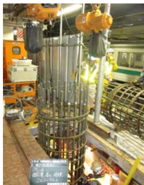
写真-4 鉄筋籠建込状況
