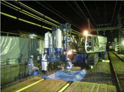
写真-1 削孔状況
