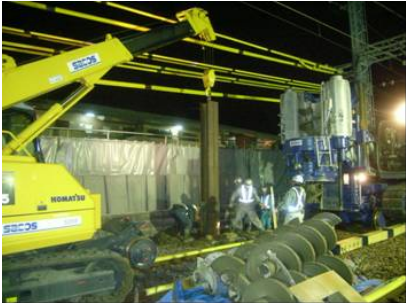
写真-2 H鋼建込み状況
