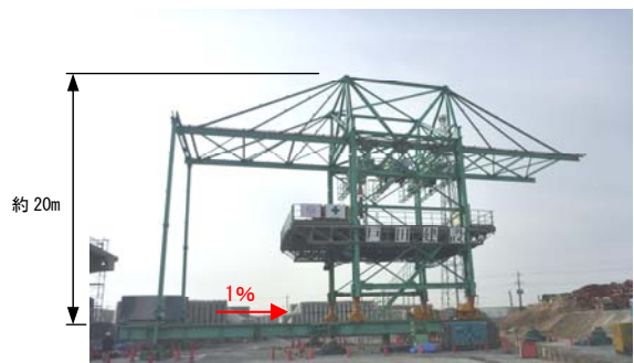
写真－1 下部工用施工機全景
