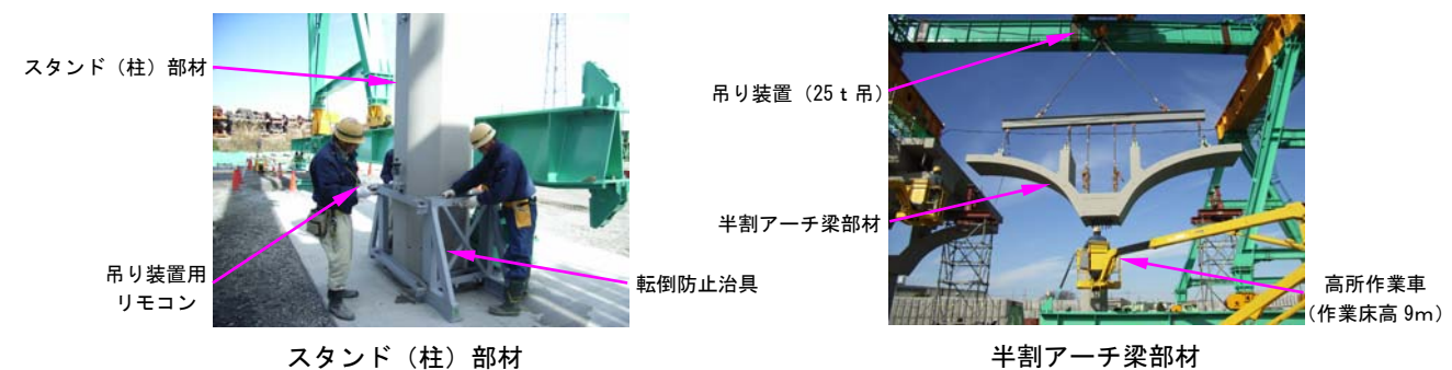
写真－２ プレキャスト部材架設状況
