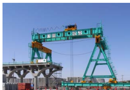
写真-1 上部工用施工機全景
