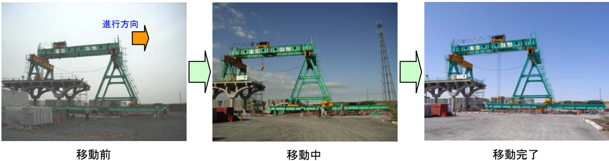
写真－３ 施工機移動状況
