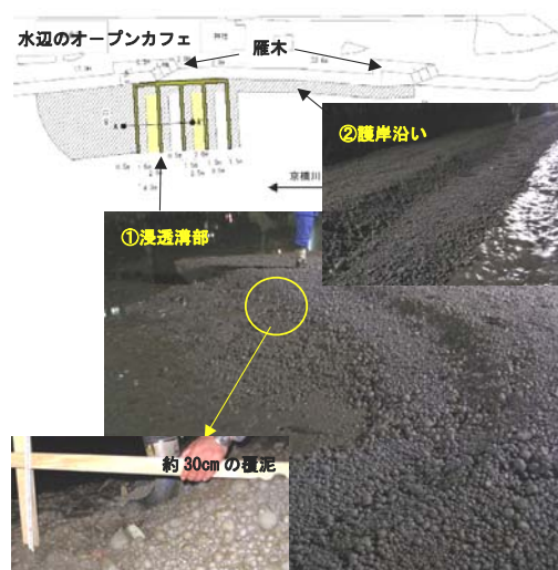
図-5 京橋川河川底質改善実証試験工事 4)
