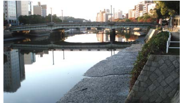
図-1 広島デルタ内河川の干潟の状況（厚く有機粘土が堆積しており、干潮時には着船場となる雁木に船が近づけない、生物層も貧弱な状態となっている。）
