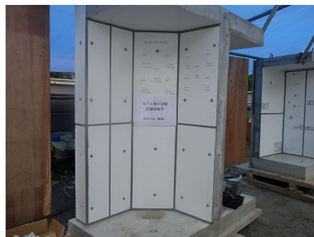
写真-3 型枠工法モデル施工完了
