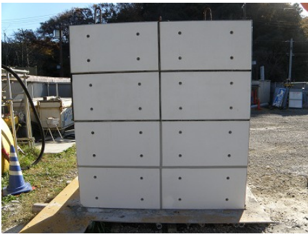
写真ー 4 埋設型枠工法モデル施工完了
