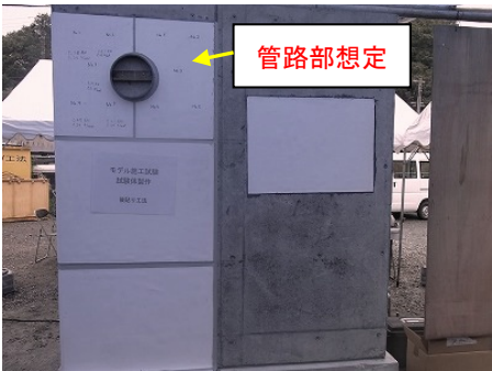
写真ー 5 後貼り工法モデル施工完了
