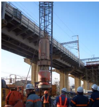
写真-1 貫入機設置状況
