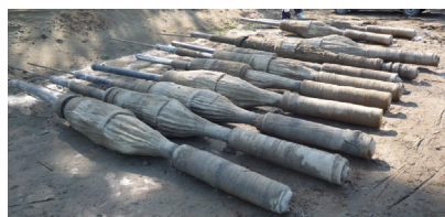
図-5 掘り起こし後の「改良体造成型」
