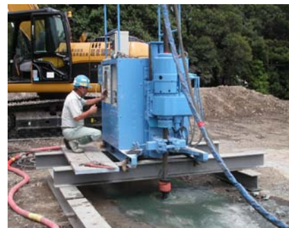
写真-1 切削試験状況
