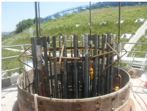
写真-3 頭部大型スパーサーの取付状況
