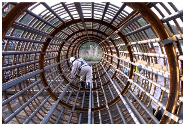
写真-2 鉄筋かご組立状況
