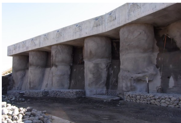
写真-4 施工後の抑止杭状況
