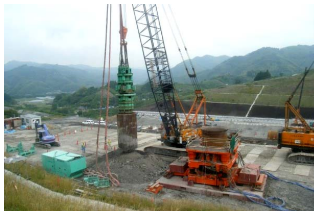
写真-1 スクリュードライバー排土状況
