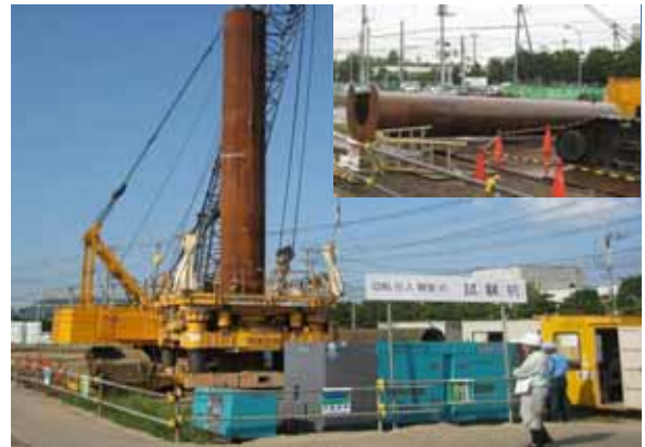
写真 1 回転圧入鋼管杭の施工状況
