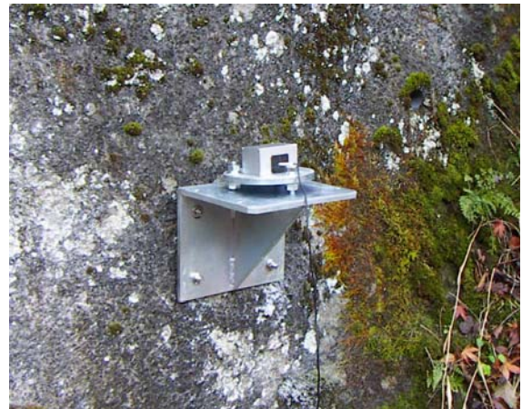
写真.1 簡易振動計（トンネル掘削の発破振動観測）
