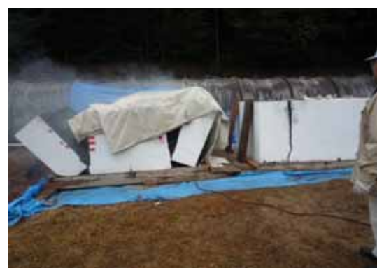
写真-5 破断面制御破砕の再現性
