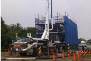
写真-2 試験打設状況
