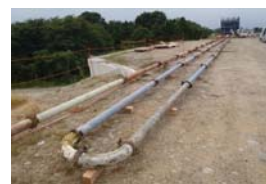
写真-1 圧送試験状況
