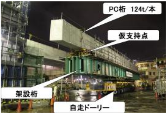
写真-1 施工状況
