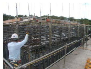
写真-1 帯筋組立吊上げ作業状況
