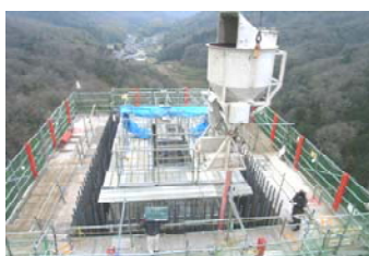
写真-2 バケットによるコンクリート打設状況
