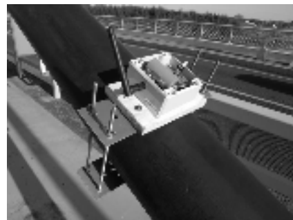
図-2 ケーブルへの設置状況
