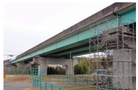
写真-1 対象橋梁
