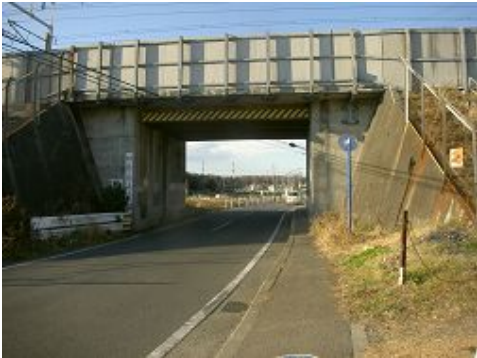
写真-1 調査対象橋りょうの一例
