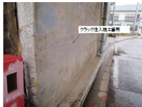
写真-3 クラック注入施工箇所
