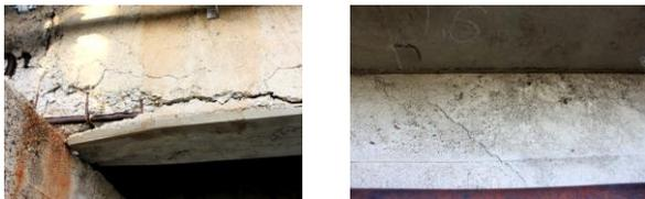
支点付近の損傷状況      せん断ひび割れ
