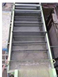
沈澱分離状況(沈澱槽)
