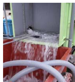
処理水発生状況(放流槽)
