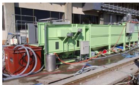
写真-2 濁水処理設備設置状況
