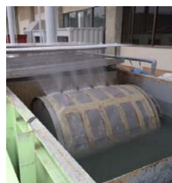
金網ろ過状況(分離槽)
