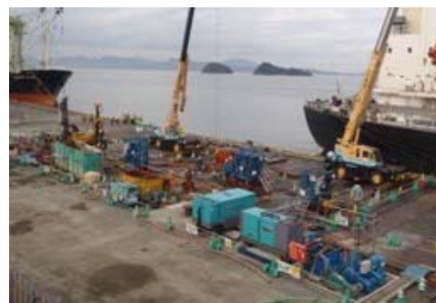
写真1 施工状況図 (ジバスタ工法)
