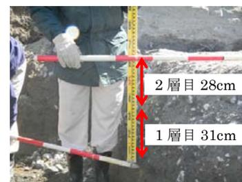
写真-6 締固め厚さ
