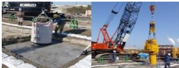
写真-3 混合材投入
