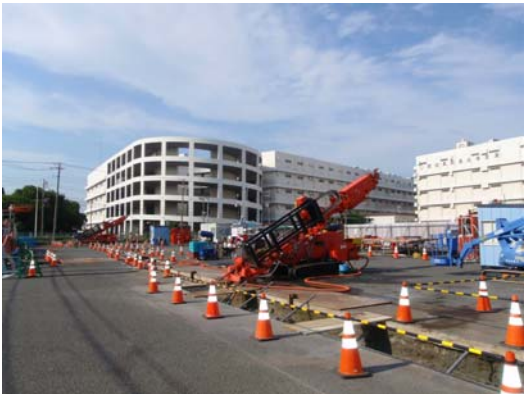
写真-1 施工状況
