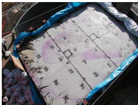
(a) 構造物下部の空洞充填 (左: 全体, 右: 表面部)
