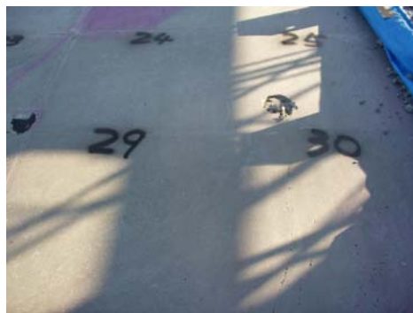
(a) 構造物下部の空洞充填 (左: 全体, 右: 表面部)
