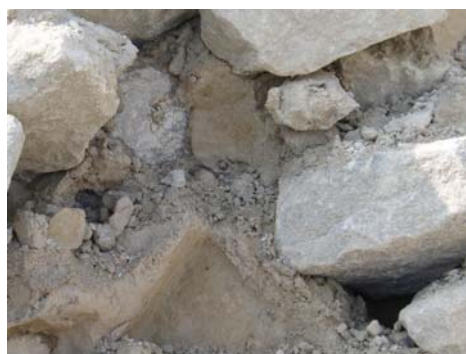
(b) 捨石護岸の間隙充填 (左: 全体, 右: 間隙部)
