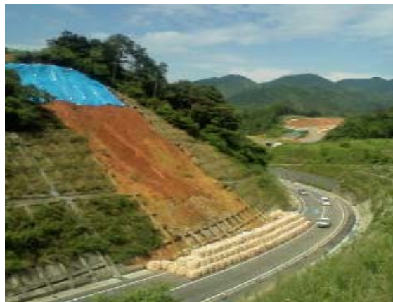
写真-2 早期に実施された仮復旧後例
