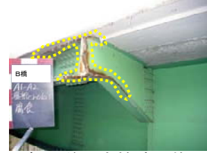
写真-9 前回点検時の状況
