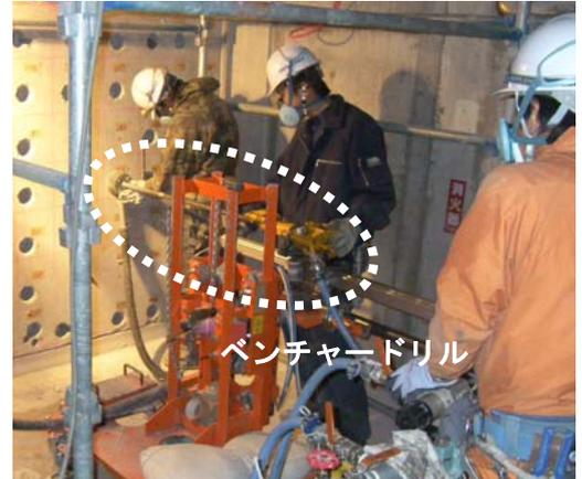
写真-2 ベンチャードリルによる削孔状況
