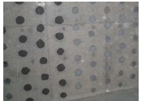
写真-7 Post-Head-bar 施工完了状況
