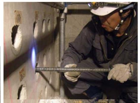
写真-5 Post-Head-bar の設置状況
