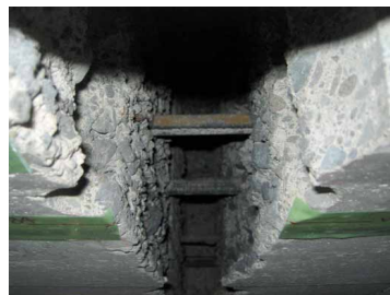
写真-3 WJ 切削完了
