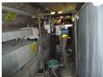
写真-1 先行コア削孔状況
