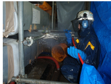
写真-2 WJ 切削状況
