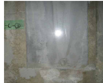
写真-6 補強完了
