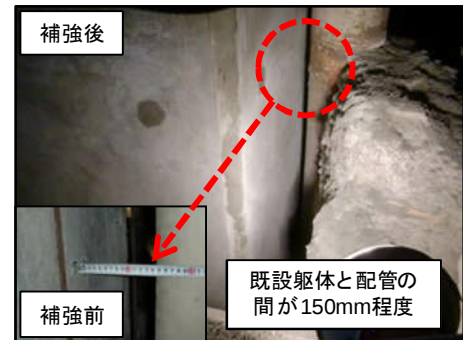
写真 - 2 狭隘部施工前後の状況
