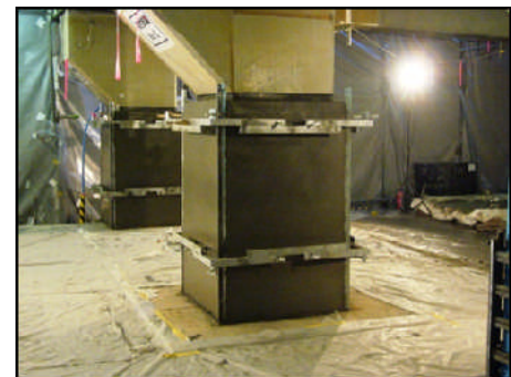
写真 - 4 吹付けモルタル施工完了状況
