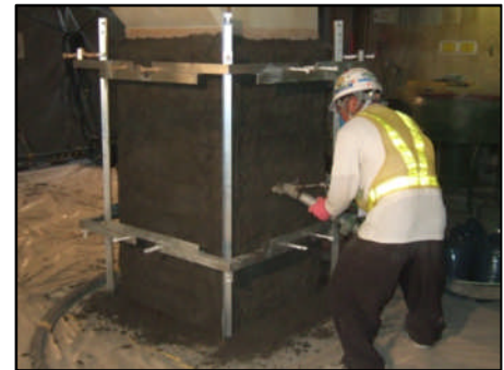
写真 - 3 吹付けモルタル施工状況
