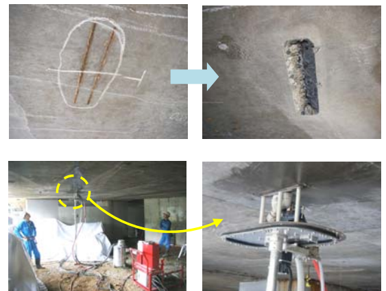
写真－1 鋼製スペーサ撤去状況
