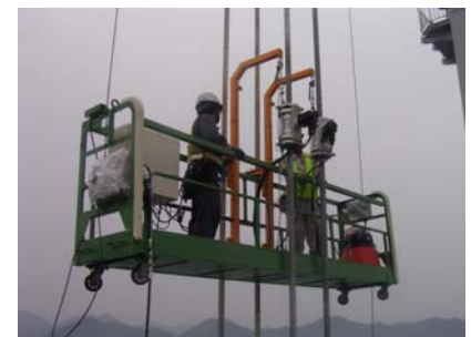
写真-3 素地調整装置全景
