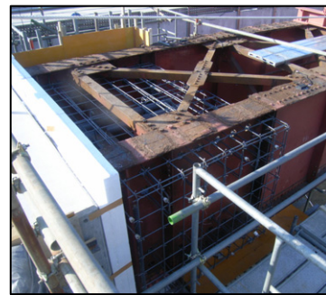
写真 4 縁切り材、ひび割れ防止筋設置
