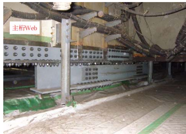
図-6 施工完了状況(バイパス材撤去前)
