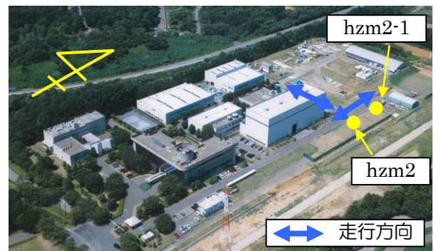
図 1 測点配置と実験ヤードの状況
