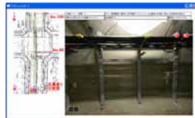
図-6 仙台市内の通信トンネル内部のジオショットFE-T
